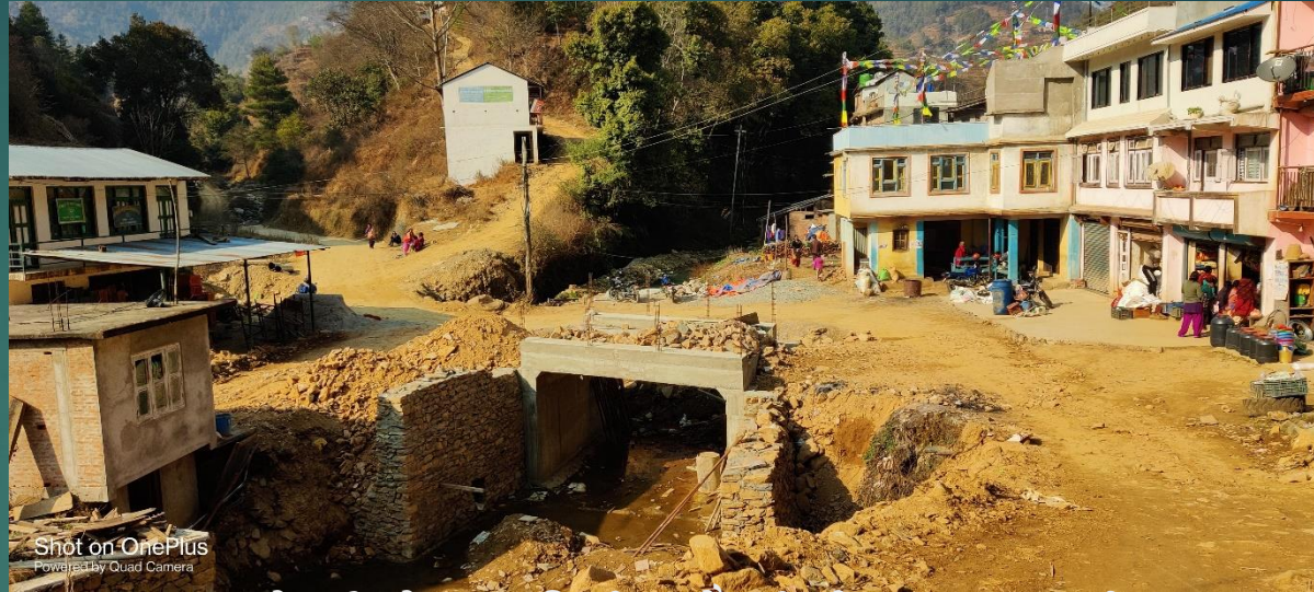
वडा नं. ५ को घट्टेखोलामा निर्माण हुदै गरेको बक्स कलभर्ट
