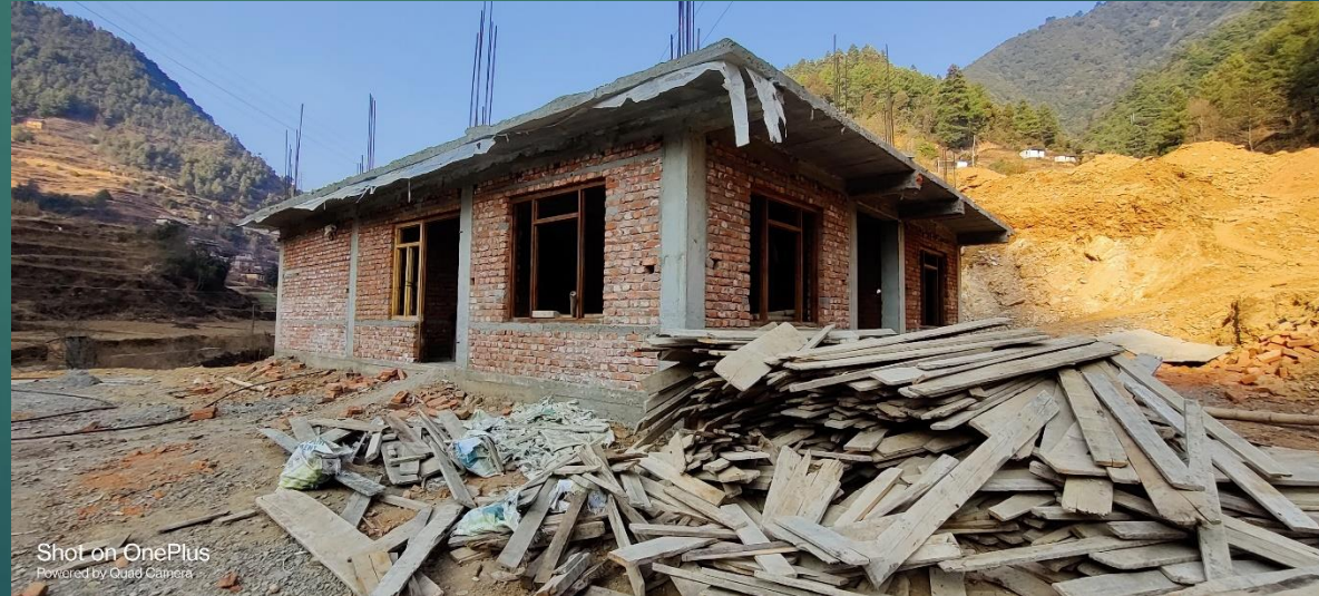
निर्माणधिन वडा कार्यालय भवन वडा नं. ५
