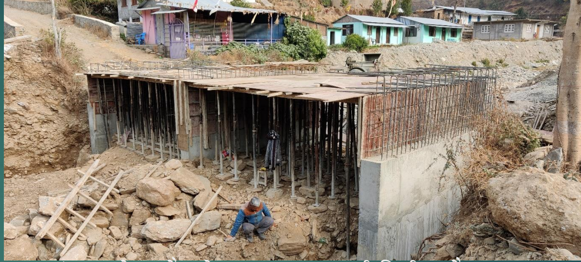
वडा नं. २ को सुकौराखोलामा बक्स कल्भर्ट निर्माण हुदै
