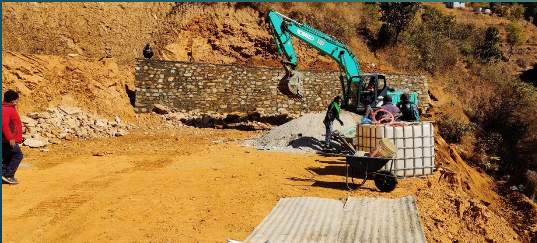
स्वास्थ्य चौकी भवन वडा नं. ५ को रिटेनिङ्ग वाल निर्माण हुदै
