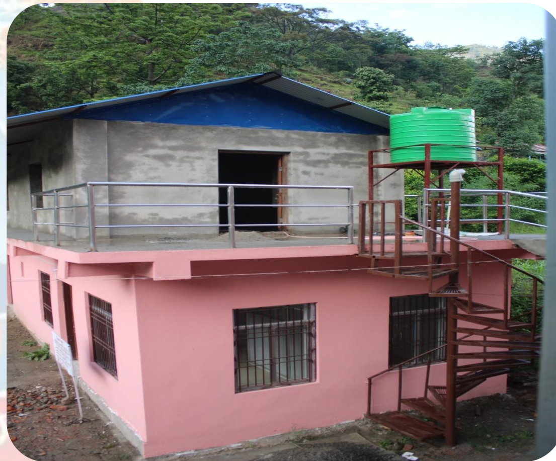
गाउँपालिका भवन विस्तार
